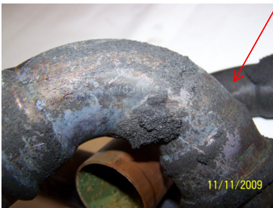
Z:\Projekte\2009-Projekte\2009-09 Le Meridien-Hotel an der Alster\Fotoanlagen Dokumentationen\Anlage 2 Rohre Schadensuntersuchung\100_6856.JPG
