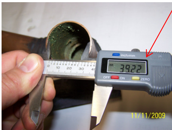
Z:\Projekte\2009-Projekte\2009-09 Le Meridien-Hotel an der Alster\Fotoanlagen Dokumentationen\Anlage 2 Rohre Schadensuntersuchung\100_6852.JPG
