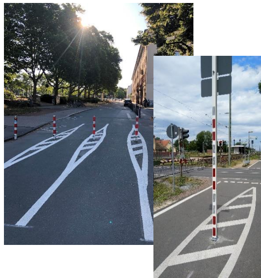
Abbildung: Warnmarkierung Sperrpfosten und reflektierender Mast
