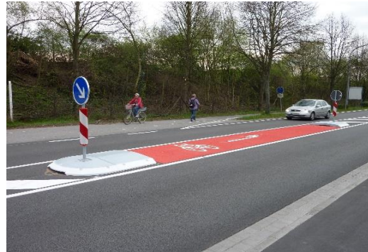
Abbildung: Beispiel einer Überführung Radweg - Fahrbahn in Heppenheim
