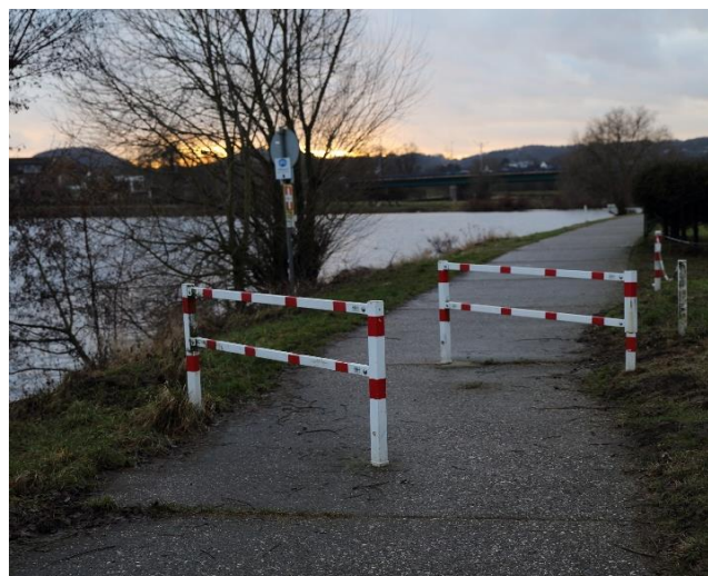
Abbildung: Beispielhafte Umlaufsperrn
