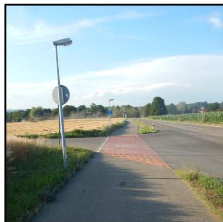
Abbildung: Straßenbegleitender Radweg im Querungsbereich in Kirchheimt unter Track
