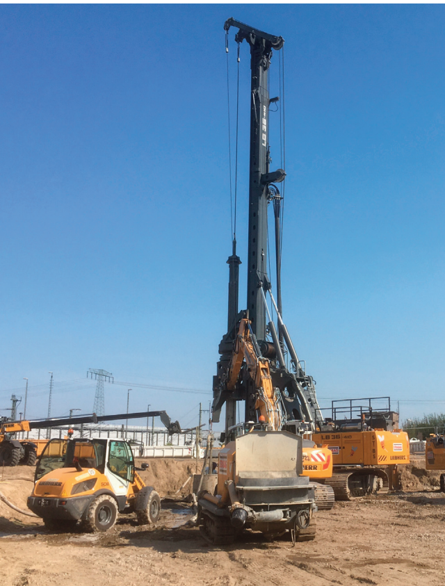
Bodensanierung im Waben- verfahren
