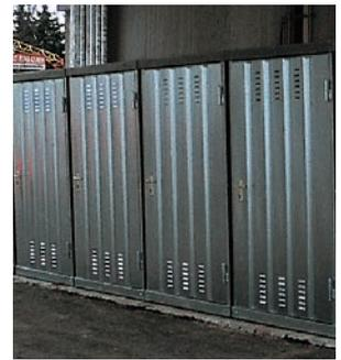
Container mit Kiemen zur Belüftung
