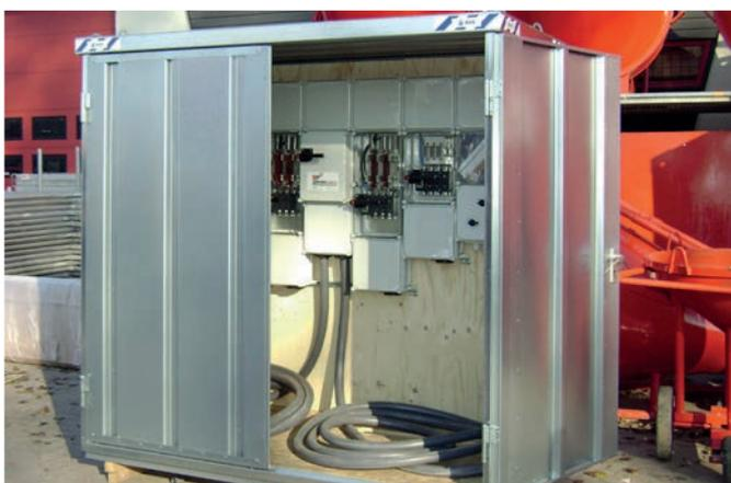
SC3000 als Einhausung für einen Stromverteilerkasten
