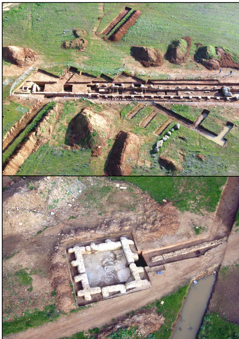
Fig. 5: Vista de algunas de las estructuras que conformaron el sistema hidráulico del área del Patriarca (R. Clapés).
