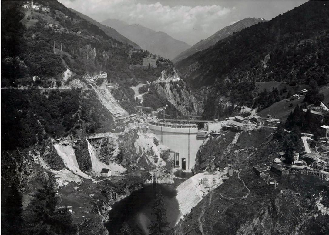
Beim Bau des Palagnedra-Stausees gelangte das Material von den Güterwagen der Centovallibahn (links oben) über Rutschen direkt zur Baustelle, um 1950.
