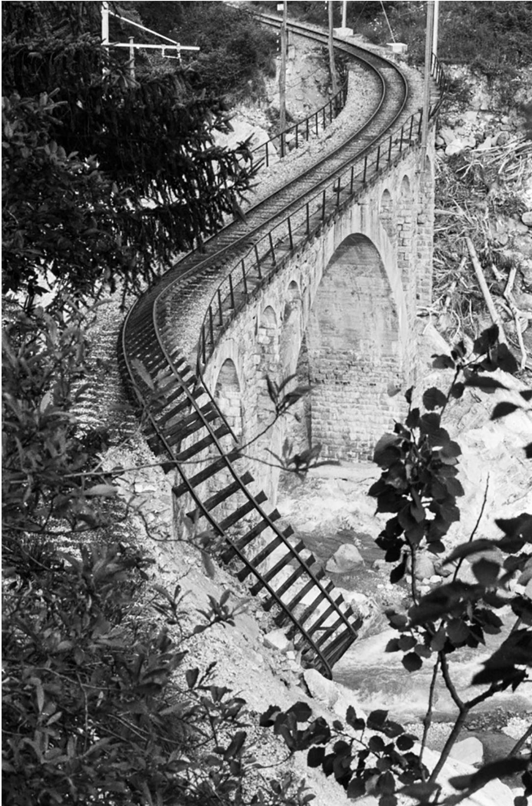
Zerstörtes Schienentrassée auf der italienischen Seite nach dem Unwetter im August 1978.
