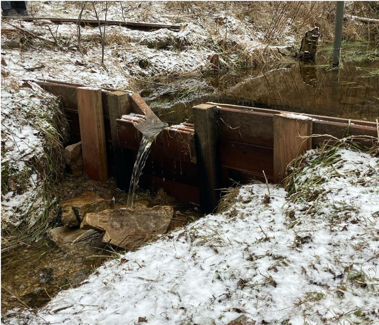
*Abb. 2: Durch Spundwand mit Überlauf verschlossener Entwässerungsgraben im Soonwald. Foto: Sabeth Häublein*
