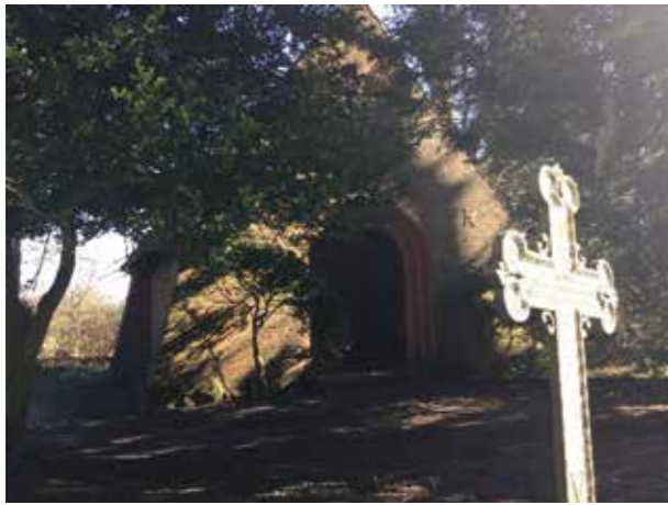
Abb. 19 Die ehemalige Leichenhalle vor der Restaurierung
