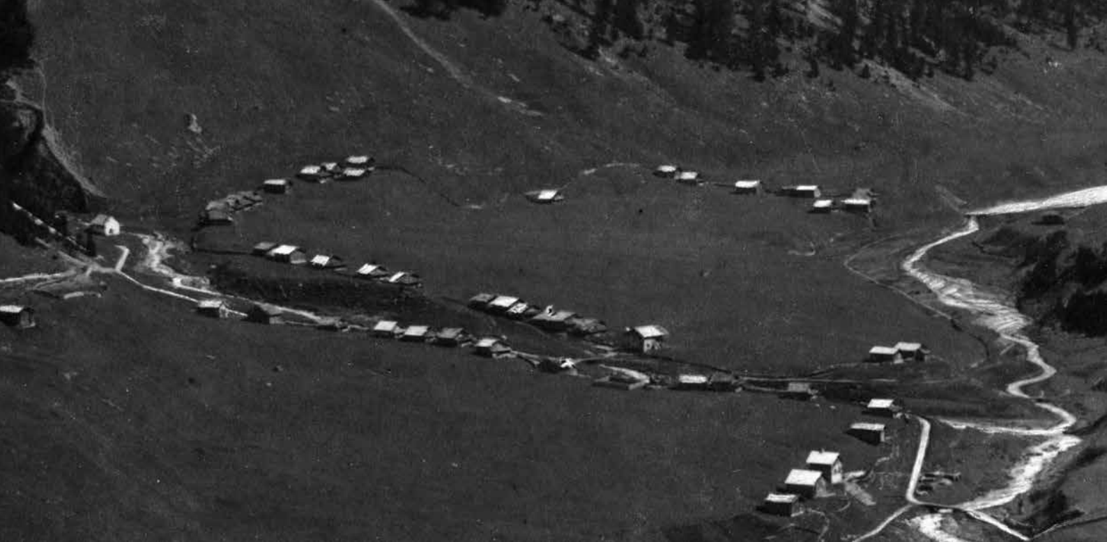
1900: Chilchli noch ohne Turm, unten rechts alte Brücke (Steg) über den Saminabach.
