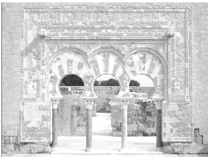
Fig. 20. Portada de la Casa de Yafar, situación previa y restauración del año 2000
