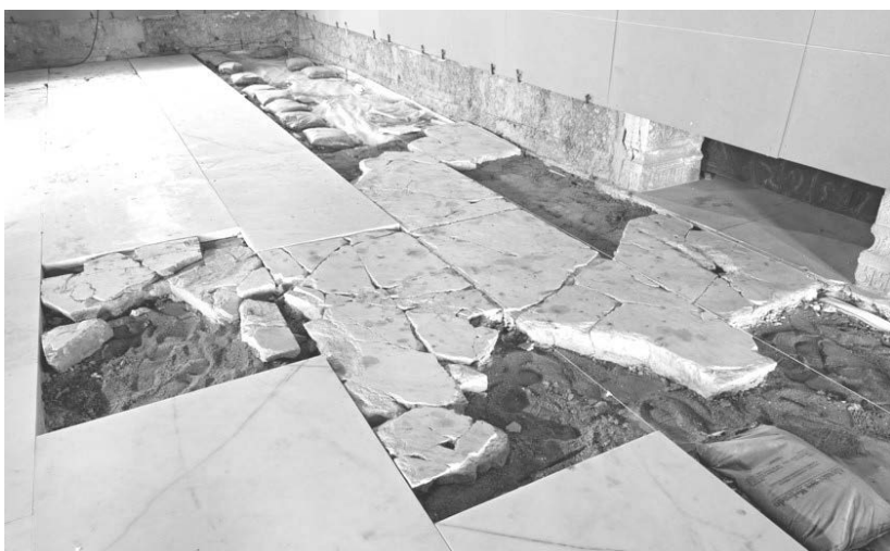
Fig. 23. Salón de Abd Al-Rahman III. Recomposición de losas de mármol originales y colocación de otras nuevas
