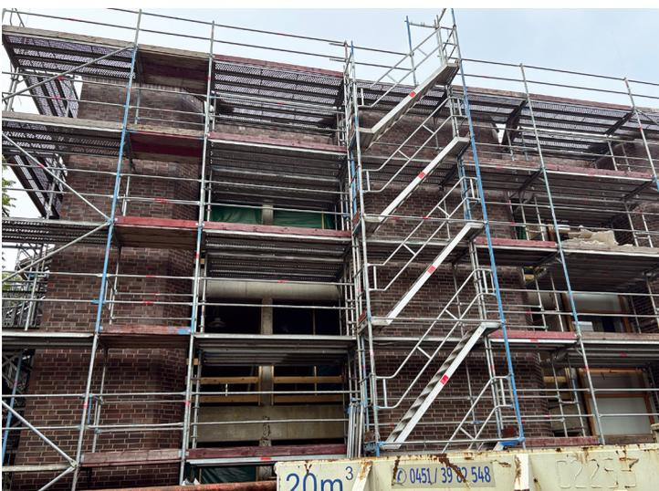
Während die Klinkerfassade erhalten bleibt, werden die ursprünglichen Fenster herausgebaut und durch neue Aluminiumrahmen ersetzt.
