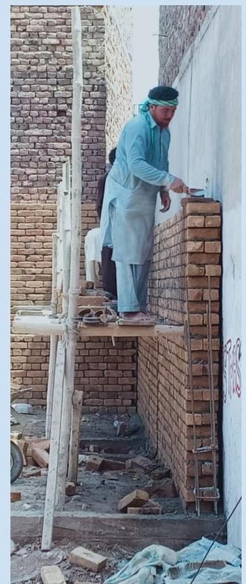
In atemberaubendem Tempo wuchs der Bau in die Höhe. Nachdem das Fundament auf 3 Meter Tiefe ausgehoben war, wurden die Mauern mit den typischen Ziegelsteinen aufgebaut. Obwohl es bis zu 40 Grad heiss war, arbeiteten bis zu 25 Arbeiter auf der Baustelle.
