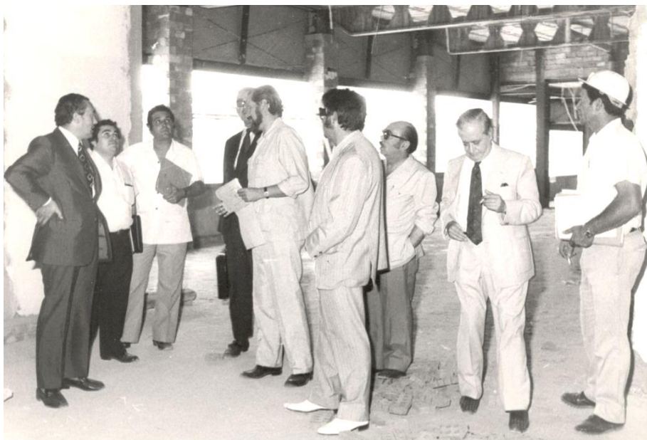
Una visita a las obras del nuevo edificio en la Torrecilla. (Foto Ricardo).
