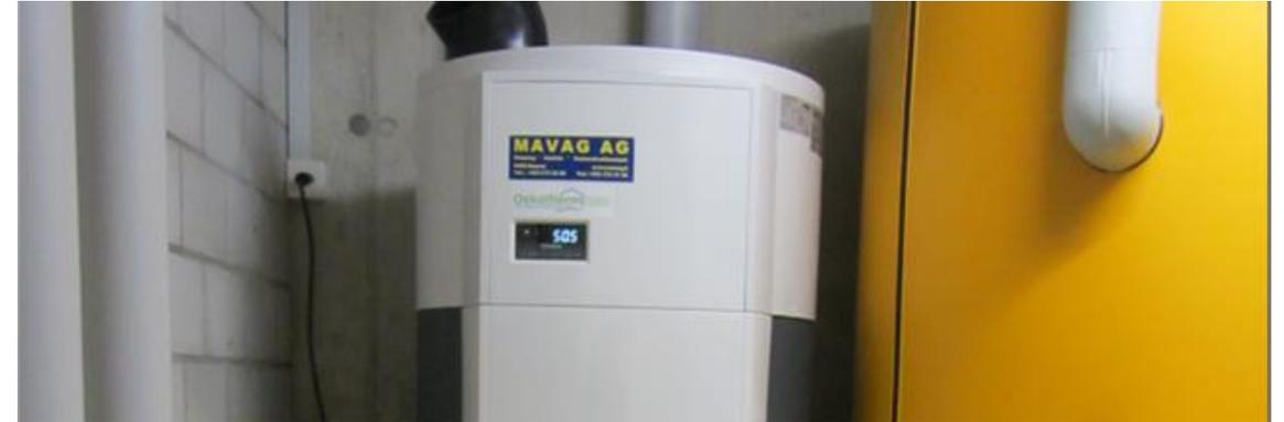
**Zentrale direkt-elektrische Wassererwärmer**
