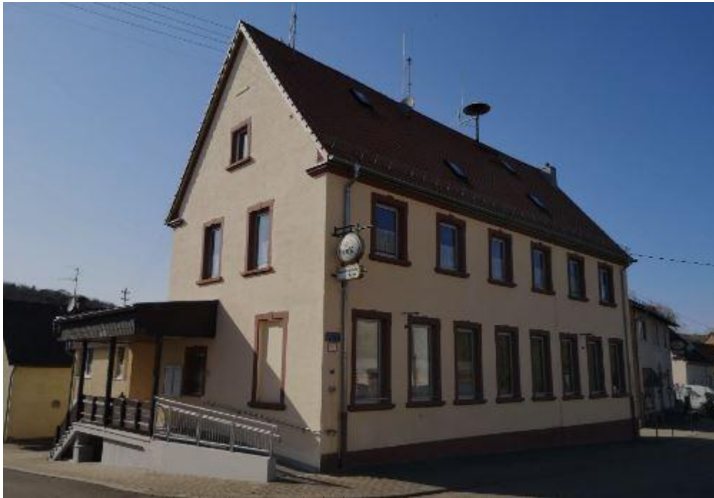
Dorfgemeinschaftshaus in Dietrichingen (Quelle: Ortsgemeinde Dietrichingen)
