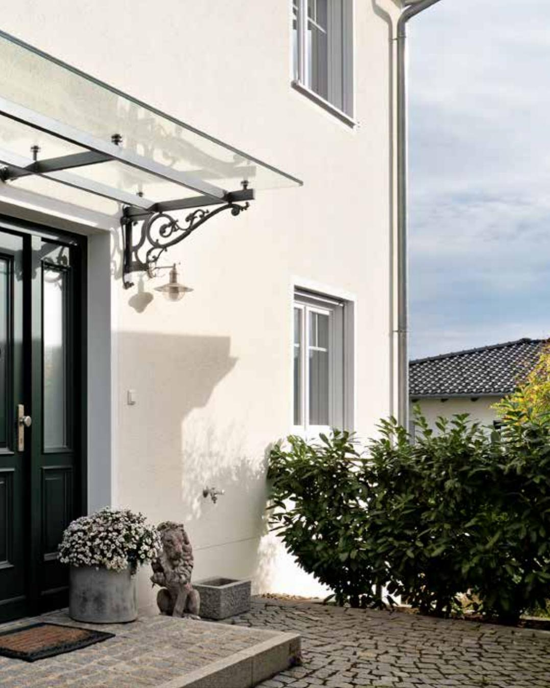
Dieses Glas-Flachdach hat eine Baubreite von 2.850 mm. Auf Kundenwunsch haben wir eine filigrane dritte Konsole installiert und die Querverstrebungen entsprechend der Traglast angepasst.
