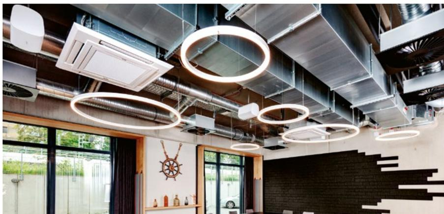
Im Erdgeschoss werden alle Bereiche mit Publikumsverkehr mit Kanaleinbaugeräten in offener Sichtmontage klimatisiert.
