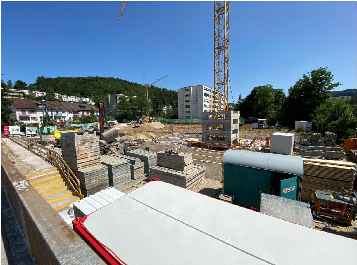
17.06. 2025: Aushub beendet, Fundament wird betoniert
