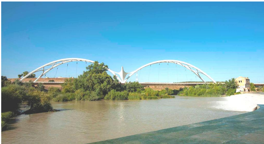
Figura 4. Puente ‘Abbās ibn Firnās sobre el Guadalquivir en Córdoba. Foto del autor.
