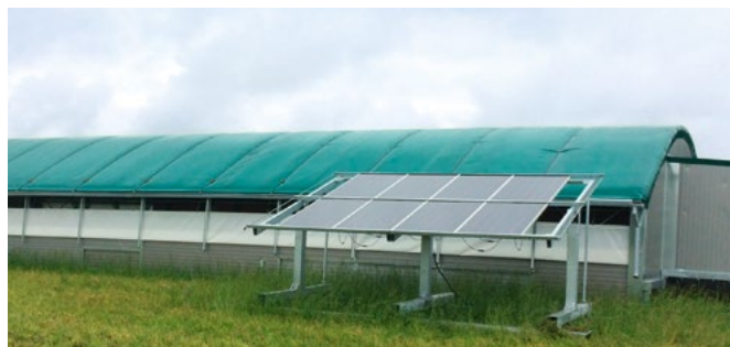
Stromversorgung eines mobilen Hühnerstalls
