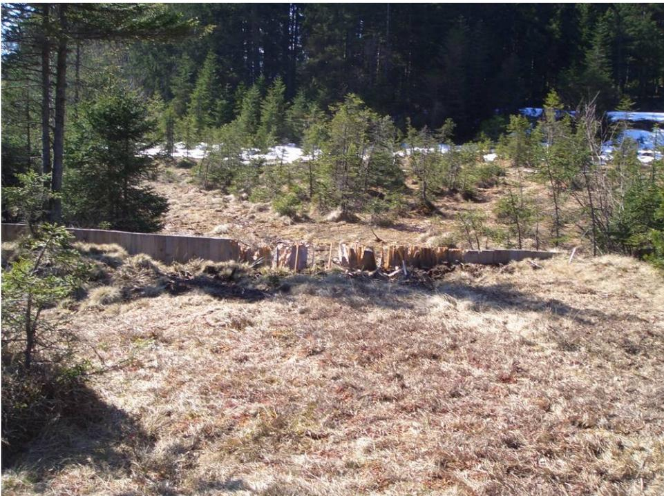
*Abbildung 4: Dämme welche mit der Pistenraupe beschädigt wurden*
