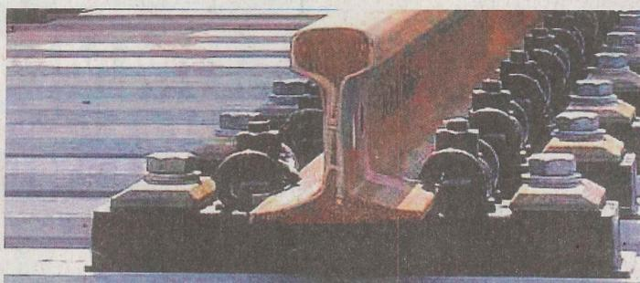
Kunststoffpuffer unter den Gleisen sollen die Erschütterungen mildern, die von der Bahn verursacht werden. Foto: Firma Voestalpine
