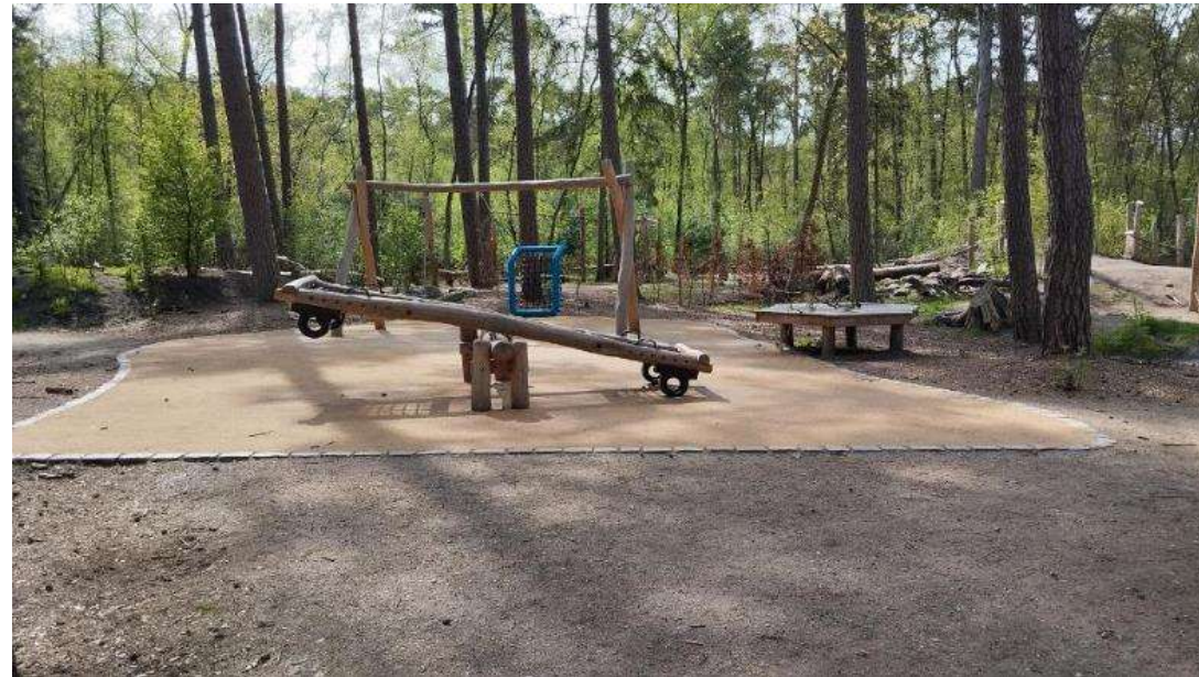
Mit Kunststoff-Gummi-Granulat versiegelt
