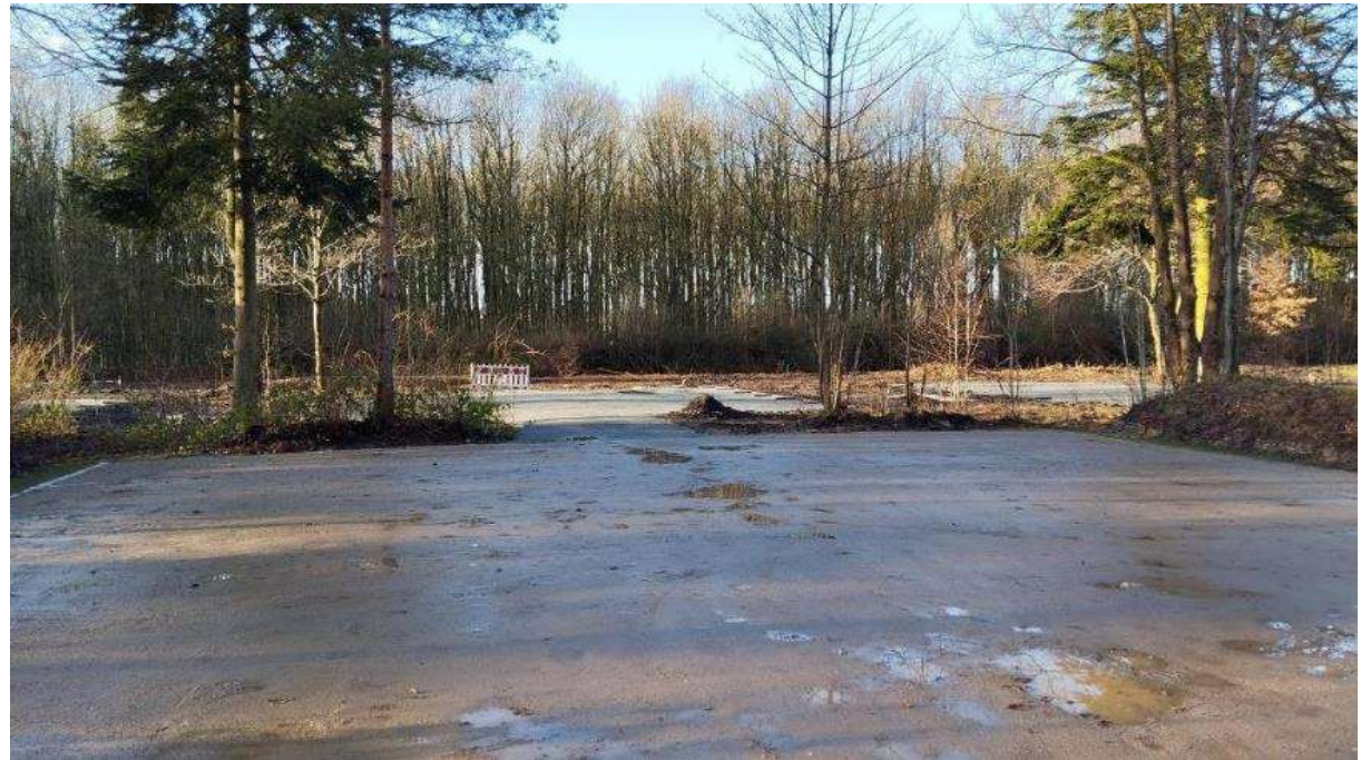
Beispiel für einen der 7 Walldurchbrüche
