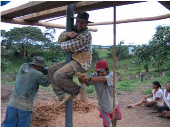
*Das Rohr für die Bohrlochverkleidung wird abgesenkt.*
