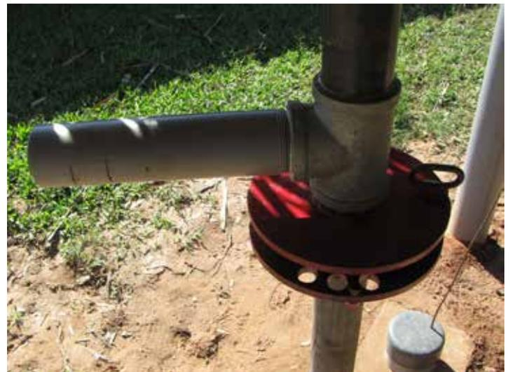
*Weil am Äquator die Sonne mitte Jahr 23.5° im Norden und Ende Jahr 23.5° im Süden steht, muss der Mast mit dem PV-Modul entsprechend dem Sonnenstand gedreht werden können.*
