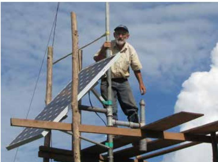
*Montage des Blitzschutzmastes und des PV-Moduls.*
