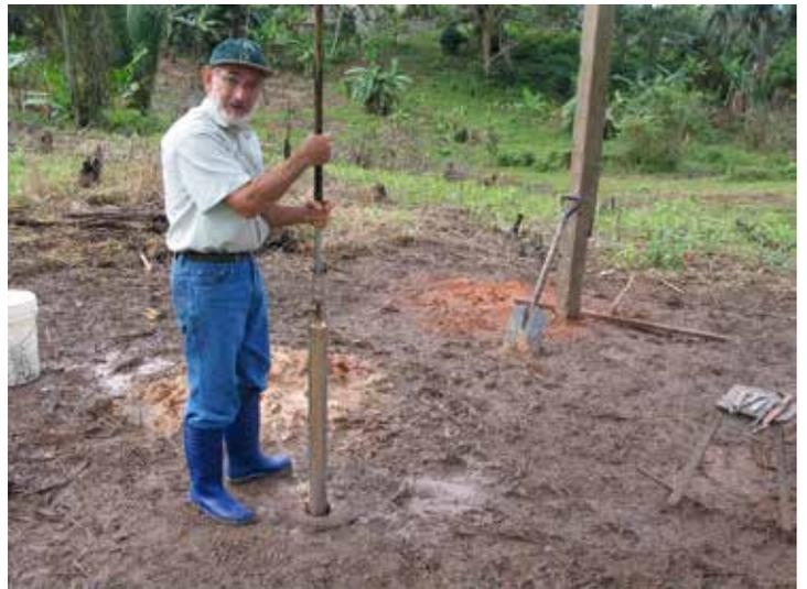
*Montage des Pumprohres und des Gestänges.*
