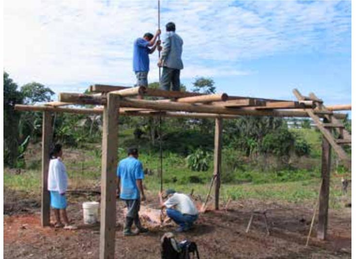
*beim Bohren nach Grundwasser mit Menschenkraft.*
