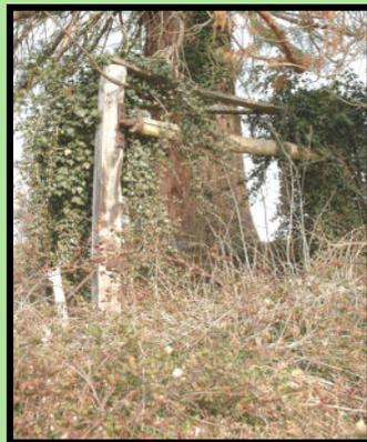
**Ce métier à ferrer est en bois complètement délabré. Le fer est complètement rouillé. De plus, il devient invisible puisqu'il est envahi par la végétation.**
