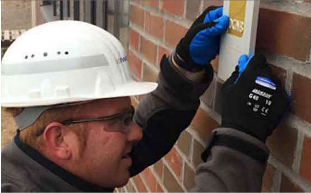
Nachhaltigkeits-Zertifikate haben sich bei Fondsimmobilien durchgesetzt. (Bild: RWE Innogy)
