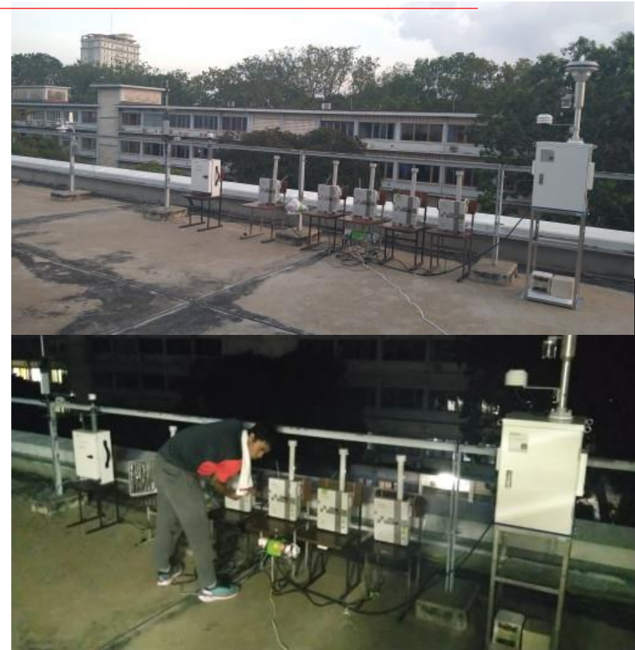
カンボジア工科大屋上にて 配置前の稼働試験
