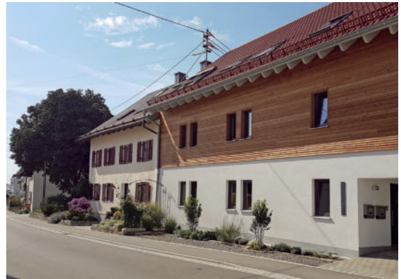
Sanierter Teil eines ehemaligen Einfristhofes im modernen Stil in Osterberg
