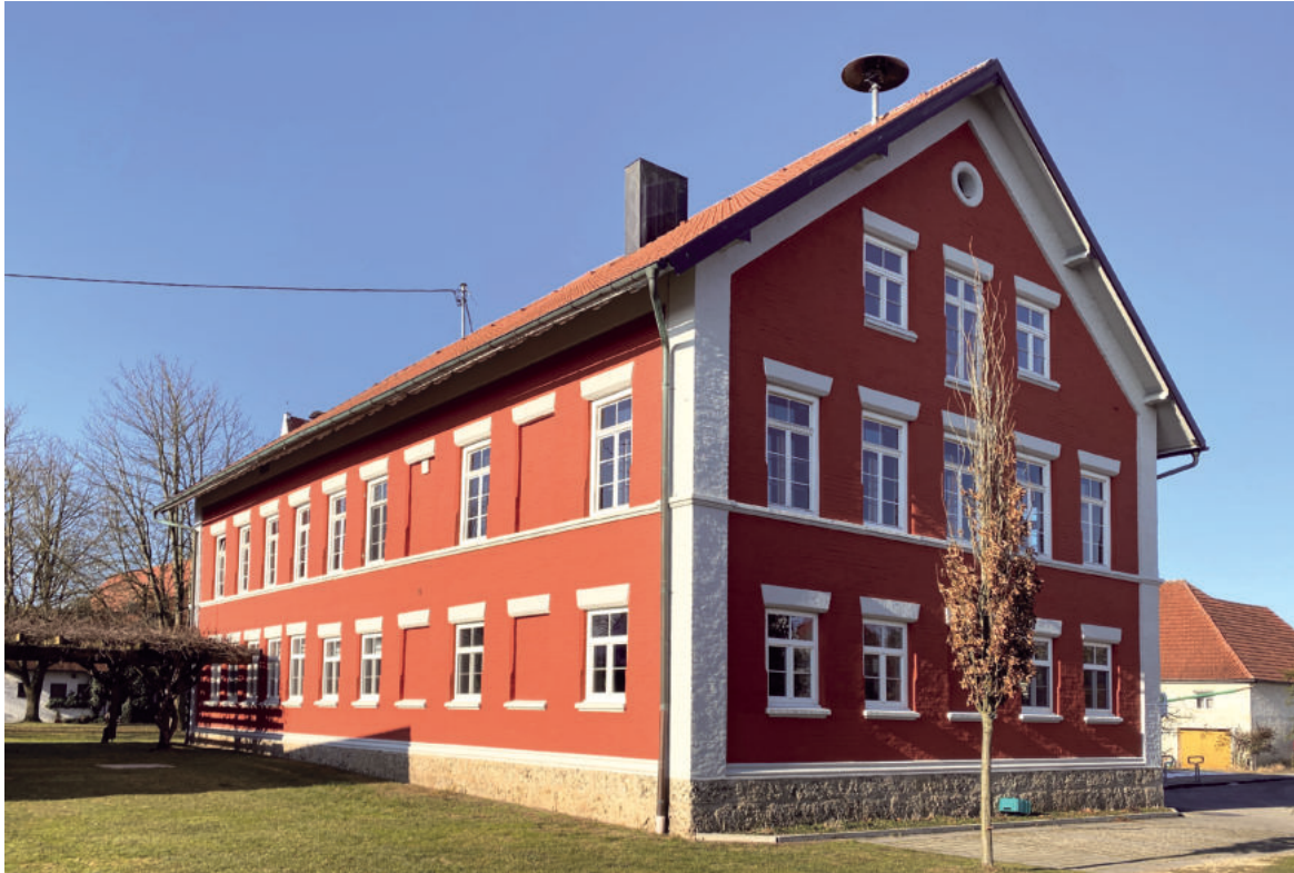
Sanierung und Umbau des ehemaligen Schulhauses als neuer Sitz der Gemeindeverwaltung Unterroth
