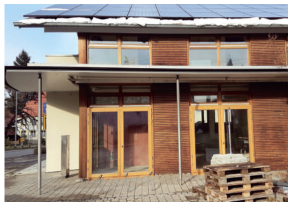
Neubau für Eisdielen im Ortskern in Obenhausen
