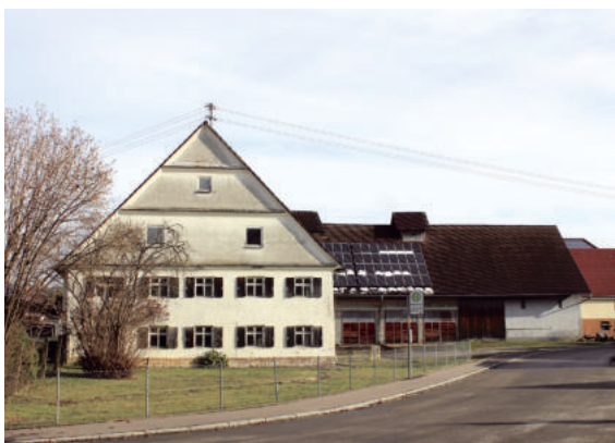
Größerer Zweifirsthof mit Dreiteilung des Giebels am Wohnhaus in Unterroth
