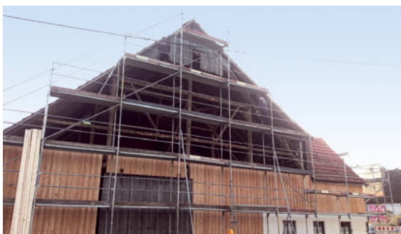
Während des Umbaus (2017)
