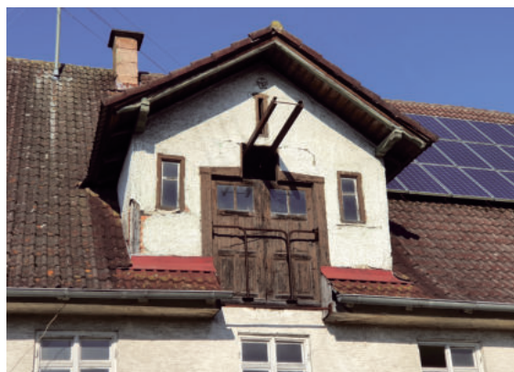
Zwerchgiebel mit landwirtschaftlichem Lastenaufzug in Unterroth
