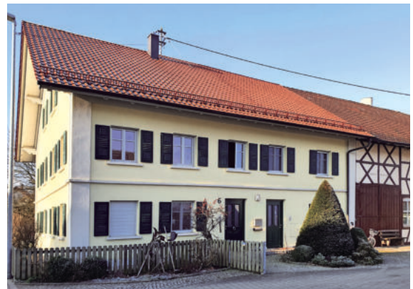
Renovierter Einfristhof mit typischen Gestaltungselementen (Fensterläden, Ecklisenen) in Jedesheim
