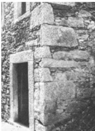
(4) Mittelalterliches Mauerwerk, grosse Eckquader mit Ausgleichsschichten, Brissago TI, 1553
