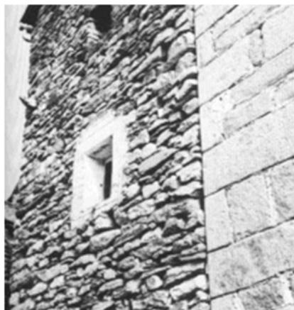
(5) Mittelalterliche Werkstein-Mauer (1424), neben späterer Bruchsteinmauer, Mergoscia TI
