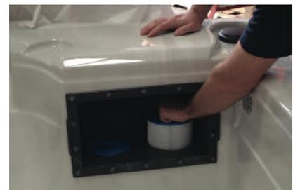
**Schritt 3.** Schrauben Sie die Filter heraus und wechseln diese
