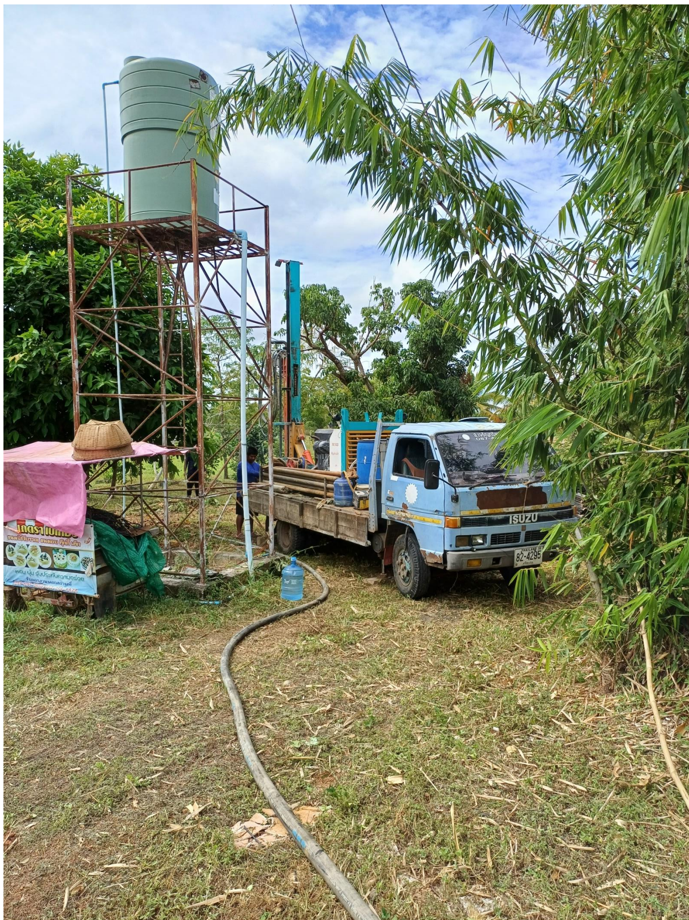
Bronwaterput boren / Drilling the deepwell / Einen Brunnen bohren > 130 mtr diep | deep | tief
