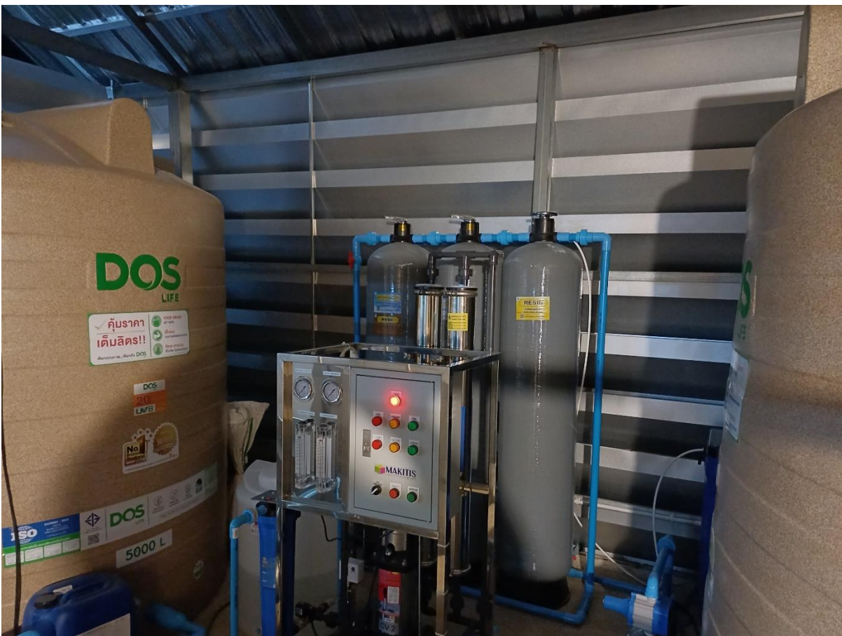
↑ Afwerking RO-shelter met jaloezie-wandpanelen voor tropenventilatie / Finish RO shelter with Venetian blind wall panels for tropical ventilation / Vervollständigung den RO-Schutzraum mit Jalousien-Wandpaneelen für tropische Belüftung ↓
