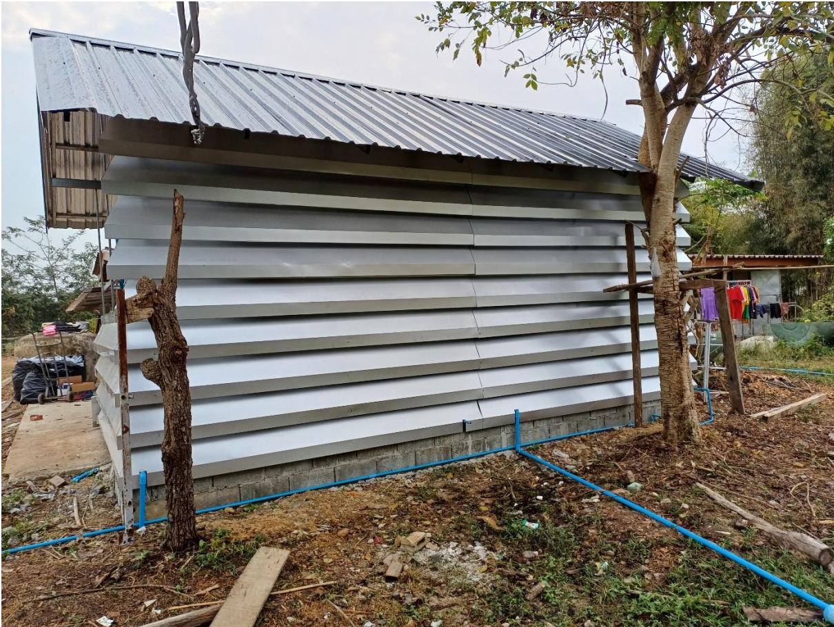
↑ Afwerking RO-shelter met jaloezie-wandpanelen voor tropenventilatie / Finish RO shelter with Venetian blind wall panels for tropical ventilation / Vervollständigung den RO-Schutzraum mit Jalousien-Wandpaneelen für tropische Belüftung ↓
