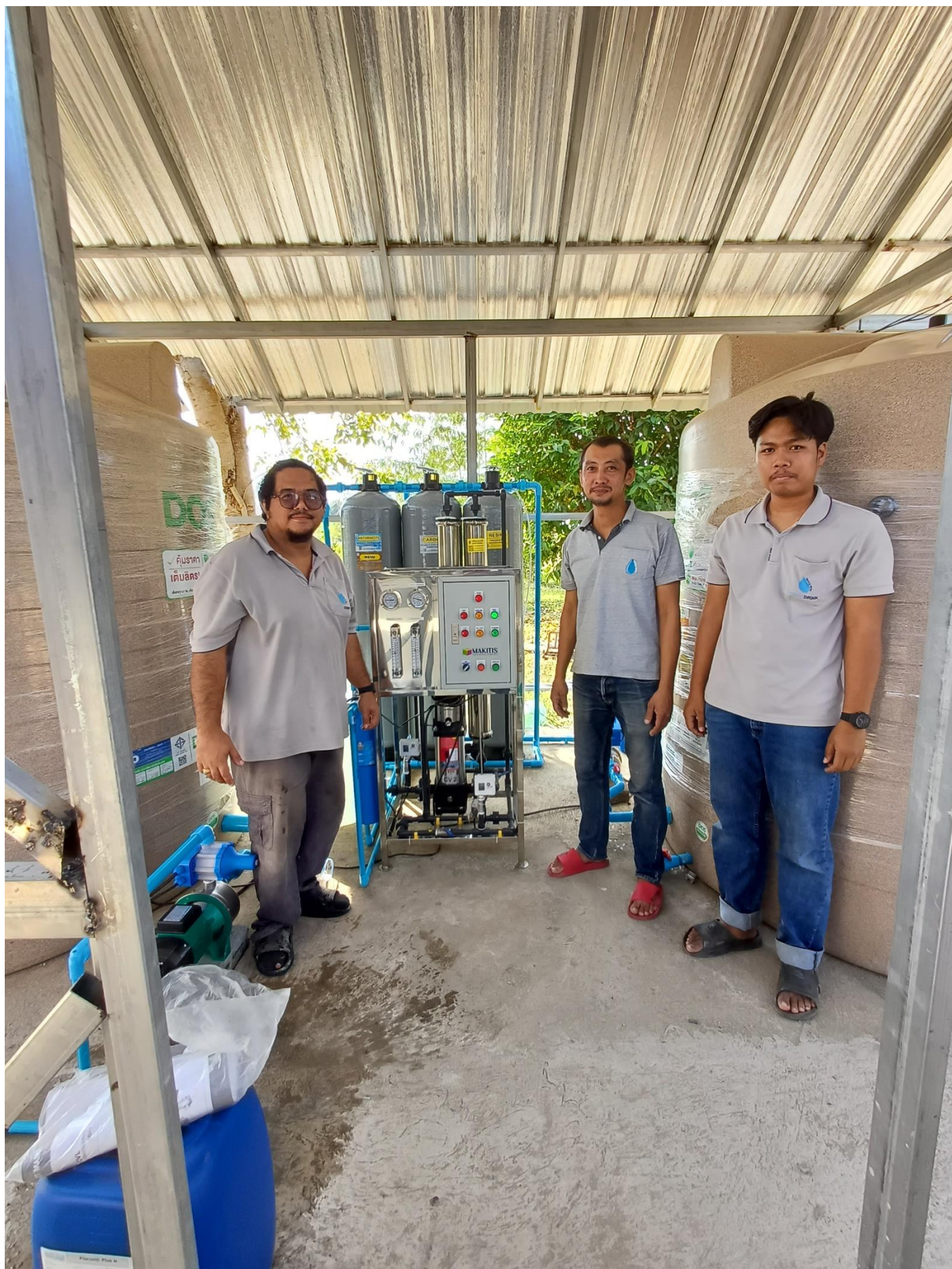
Het SafetyDrink installatieteam / The SafetyDrink installation team / Das SafetyDrink-Installationsteam
