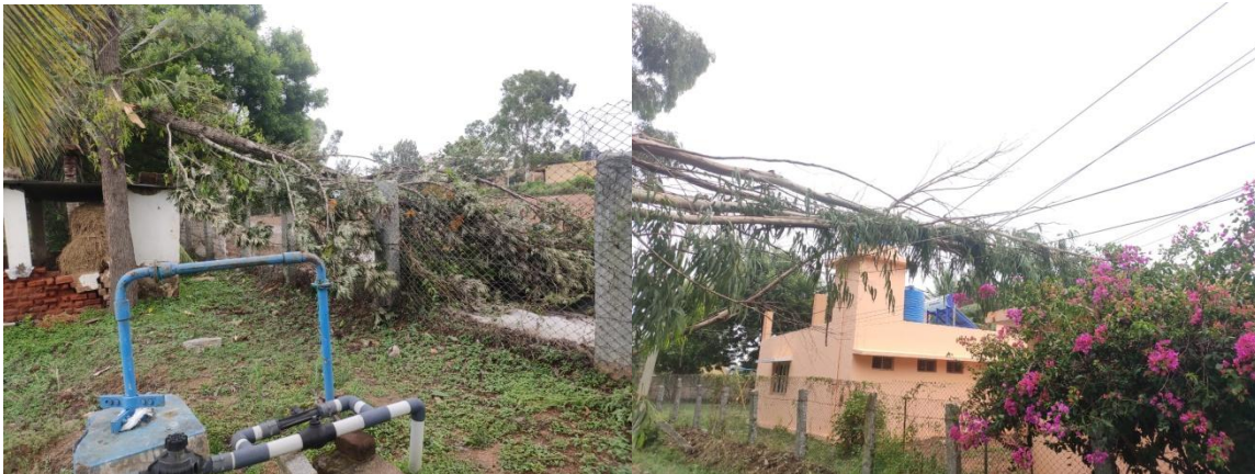
Neuerliche Sturm- und Stromleitungsschäden Anfang Mai 22
