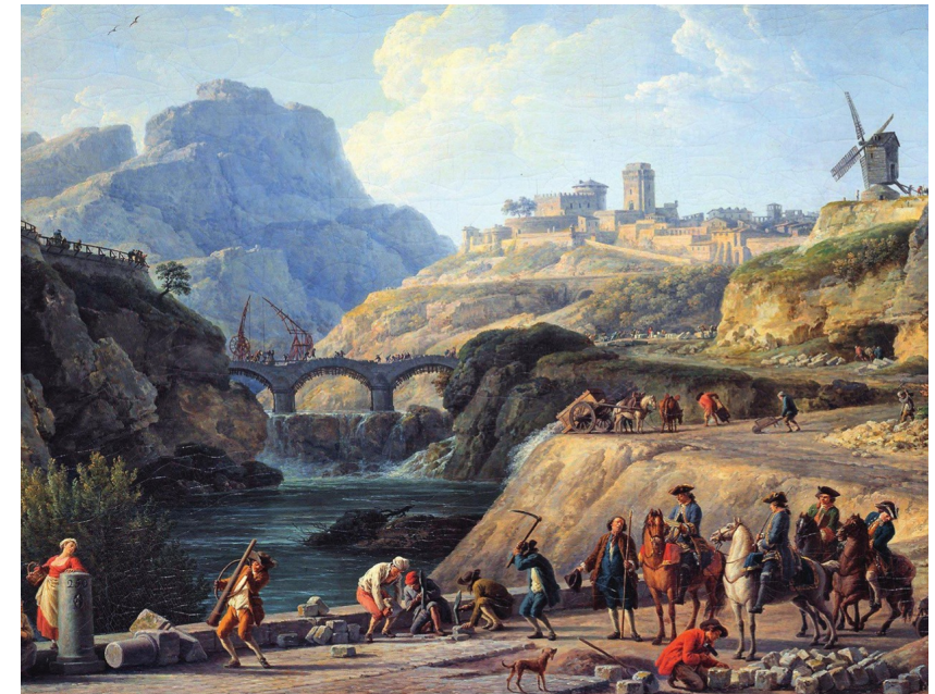
4 La construction d'une route (Huile sur toile, Joseph Vernet, 1771, Musée du Louvre) Au XVIII e siècle, l'État royal améliore le réseau routier, à l'aide des paysans qui fournissent la corvée royale. En 1776, Turgot supprime les corvées et les remplace par un impôt payable par tous.
