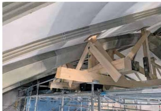
Durch eine spezielle Stützkonstruktion müssen die Zimmerleute das außergewöhnliche Dach der St. Patriciuskirche entlasten (linkes Foto), um die Fäulnisschäden an den Auflagepunkten der Dachkonstruktion (rechtes Foto) beheben zu können.
