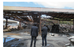
事務所や倉庫などが全焼した被害現場（4/3）
