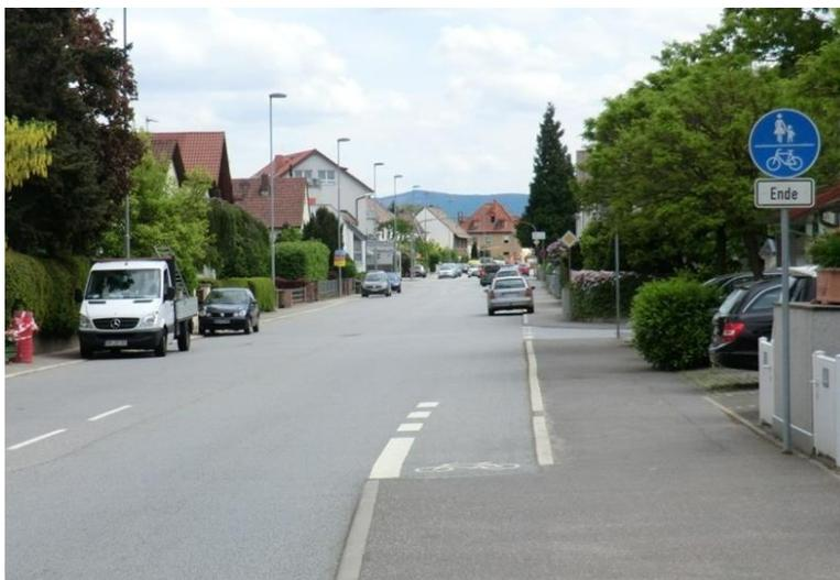
Abbildung 33: Beispiel einer markierten Ausleitung auf die Fahrbahn in einer hessischen Gemeinde (Foto: R+T)
