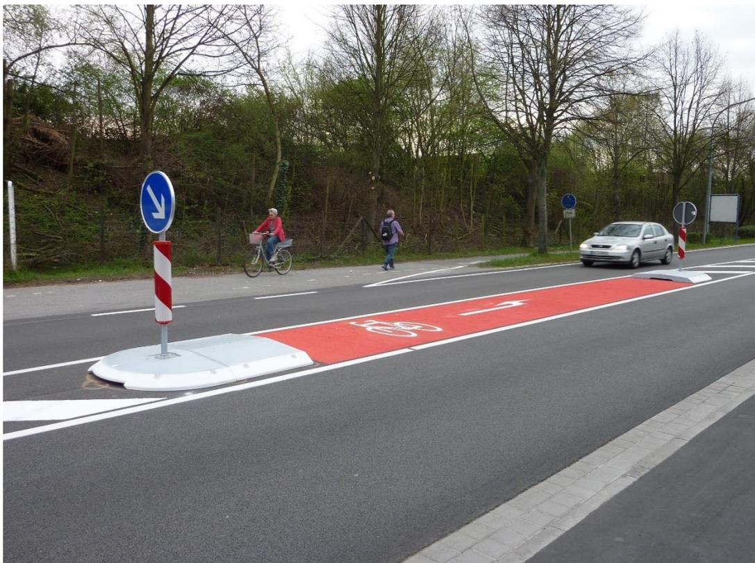
**Abbildung 35: Hessisches Beispiel einer Mittelinsel mit Aufstellfläche zum Linksabbiegen (Foto: R+T)**
