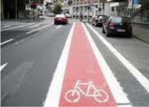
Werden Radfahrstreifen an Straßen mit starkem Kraftfahrzeugverkehr angelegt, ist ein breiterer Radfahrstreifen vorzusehen oder ein zusätzlicher Sicherheitsraum zum fließenden Verkehr zu schaffen. Radfahrstreifen sind in Kreisverkehren nicht zulässig. Trotzdem kann Radverkehr in Kreisverkehren auf der Fahrbahn geführt werden (siehe **Kapitel 2.4**).
