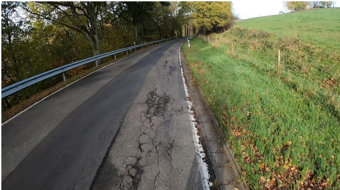
**Abbildung 45: Schäden vor allem im Randbereich der Fahrbahn der L467 bei Wiesbach [Foto: R+T]**
