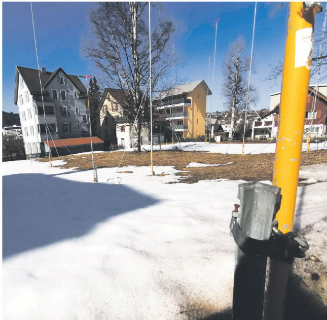
Mit der Kreditgewährung hat die Stiftung Phönix für ihren Neubau auf dem Einsiedler Gotthardstallareal (Aufnahme) eine weitere Hürde genommen.
