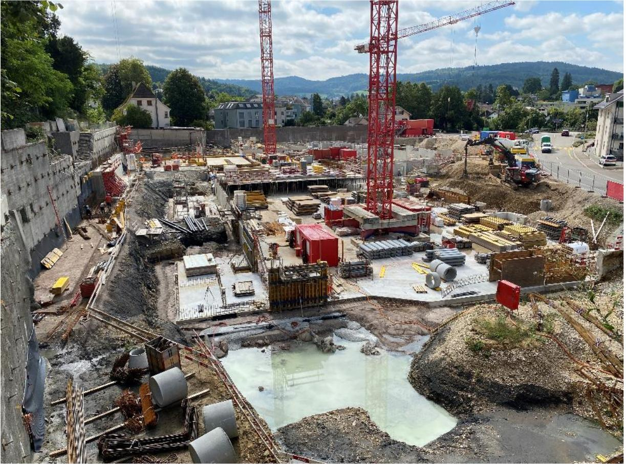
20. August 2024: Hangabsicherung. Erste Decken werden betoniert
