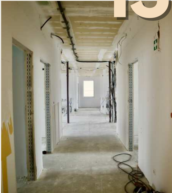
LEIPZIG | SELEKTIVER RÜCKBAU
