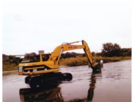
庄内川へ重機
