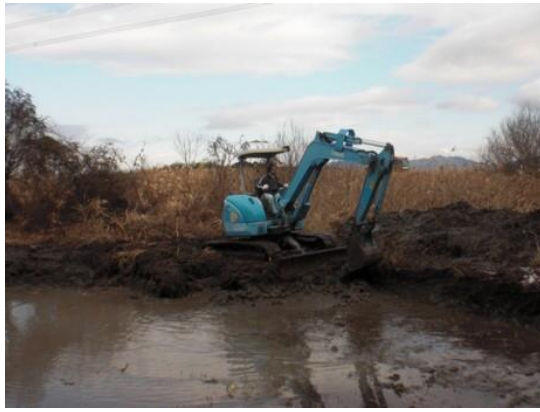
重機を入れてのビオトープ試験場整備
