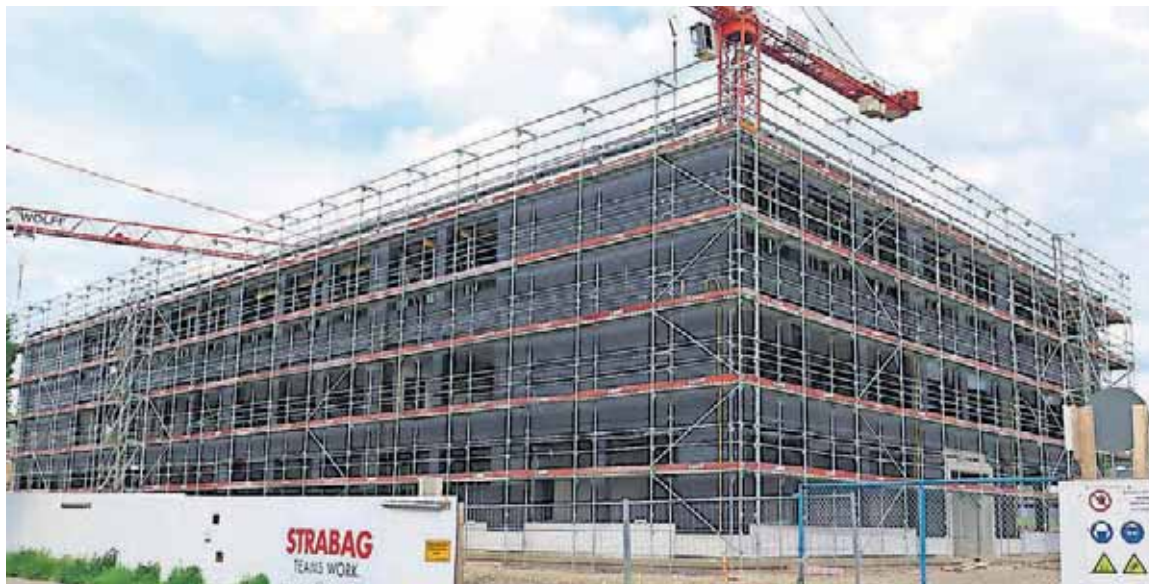
Blick auf den Schulhastrakt vom Bodenacherring aus gesehen. Die drei Geschosse sind im Rohbau bereits errichtet.
