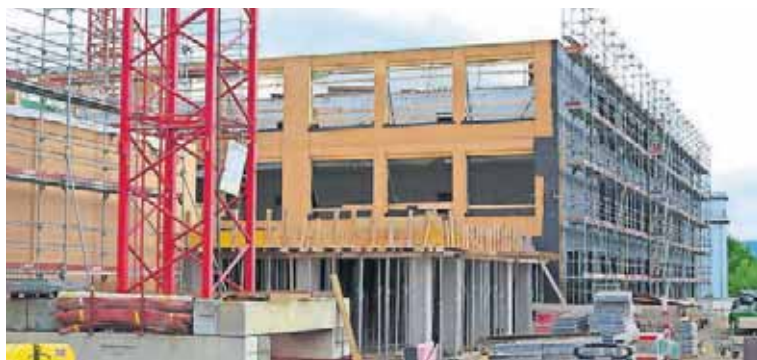
Westansicht des neuen Schulhauses: Vorne entsteht der Eingangsbereich und links anschliessend die Turnhalle.
