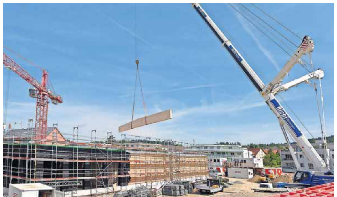
Mit einem 40-Tonnen Spezialkran wurden die rund acht Tonnen schweren Holzträger vom Schwertransporter auf der Zürichstrasse über den Schutzwall auf den Rohbau der Turnhalle gehievt. (Fotos: Reto Hoffmann)
