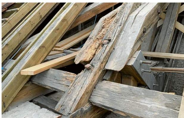
Eindringendes Wasser ist der Grund für die Schäden an der komplexen Dachkonstruktion. Die Zimmerleute arbeiten mit Stützkonstruktionen wie dieser auf der Westseite, um die Last des Daches abzuleiten. FOTOS: JENS SCHLEHE
