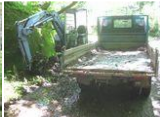
写真-4⑥ 重機の導入
