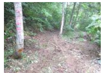
写真-4⑦ H28.8大雨、旧道崩落。仮迂回路設置。
