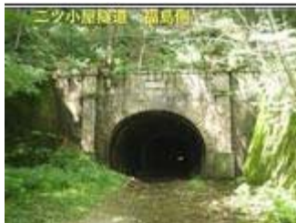
写真-5② ニツ小屋隧道(福島側)
