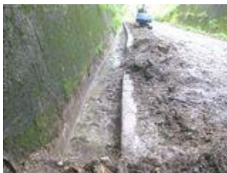
写真-4③ 側溝の整備
