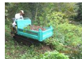
写真-4⑧ 旧大平集落跡付近崩落箇所の復旧
