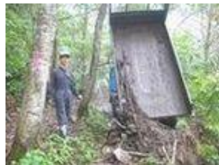
写真-4⑤ 旧道崩落箇所の仮復旧
