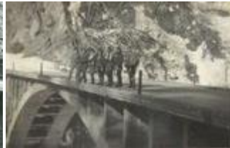
写真-8⑦ 高欄喪失・新沢橋(戦時中供出)、昭和30年代前半 大滝会提供
