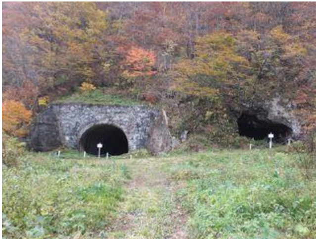
写真-8① 栗子隧道米沢側坑口、左側昭和2代目・右側明治初代
