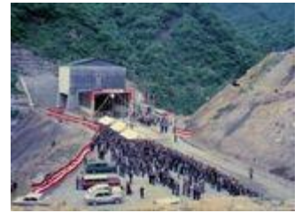
写真-3⑤ 昭和41年5月29日開通式 (東栗子トンネル福島側竣工式)
