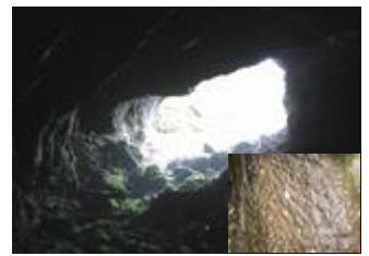
写真-5⑥ 栗子隧道内部から望む
