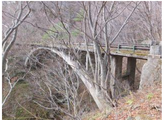
写真-5⑧ 第3代目新沢橋(昭和の大改修 S11.12 完 L=42m, W=6m)
