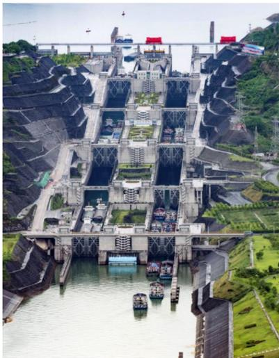
Le barrage des Trois Gorges est ouvrage de 2 310 mètres de long qui coupe le Yangtse, avec une puissance de 22 500 mégawatts. Le double escalier d'écluses à cinq niveaux permet le passage de bateaux de 10 000 tonnes. De nombreux villages et villes, des terres agricoles, des sites historiques ont été inondés par le lac qui s'est formé en amont du barrage. 1,6 millions d'habitants ont été déplacés.
