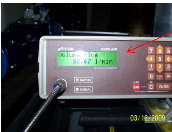
Z:\Projekte\2009-Projekte\2009-09 Le Meridien-Hotel an der Alster\Fotoanlagen Dokumentationen\Anlage 4 Durchflußmessungen\100_7360.JPG
