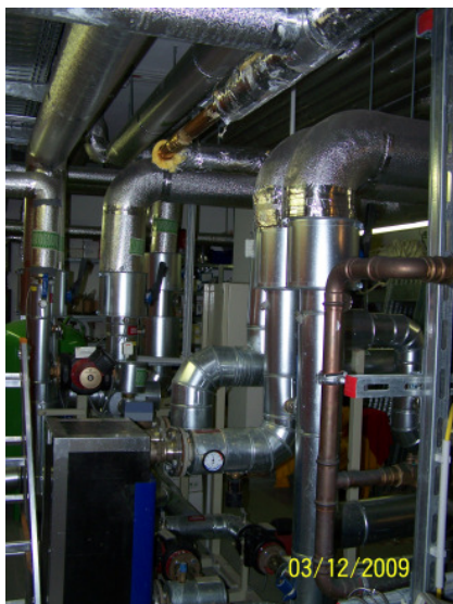
Z:\Projekte\2009-Projekte\2009-09 Le Meridien-Hotel an der Alster\Fotoanlagen Dokumentationen\Anlage 4 Durchflußmessungen\100_7397.JPG
