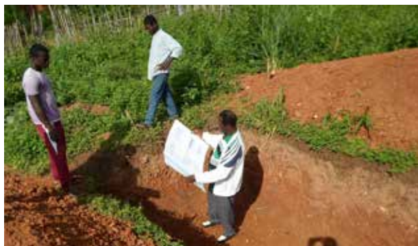
Die Bauarbeiten beginnen mit dem Aushub für die Fäkaliengrube
