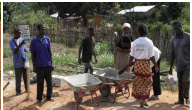
Bewohner aus der Umgebung helfen bei den ersten Bauarbeiten
