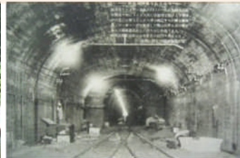
隧道内信号所
