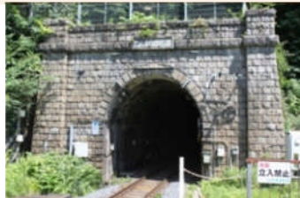
仙山隧道山形坑門
